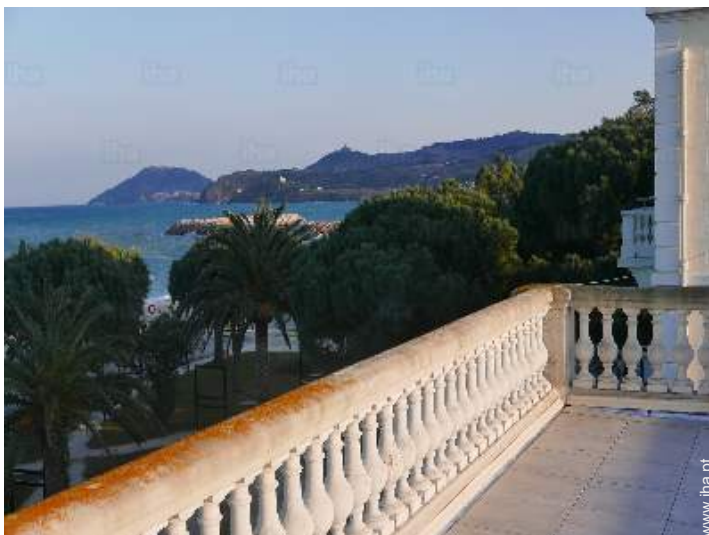
vista a partir do terraço sobre telhado
